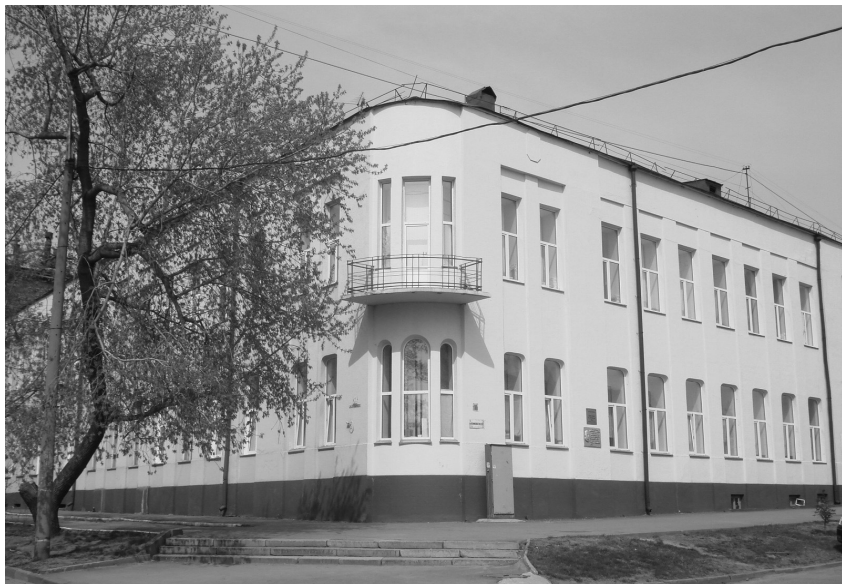
Рис. 2. Современный вид здания жилого дома А. И. Кагана (Фотография автора, 2008 г.)
